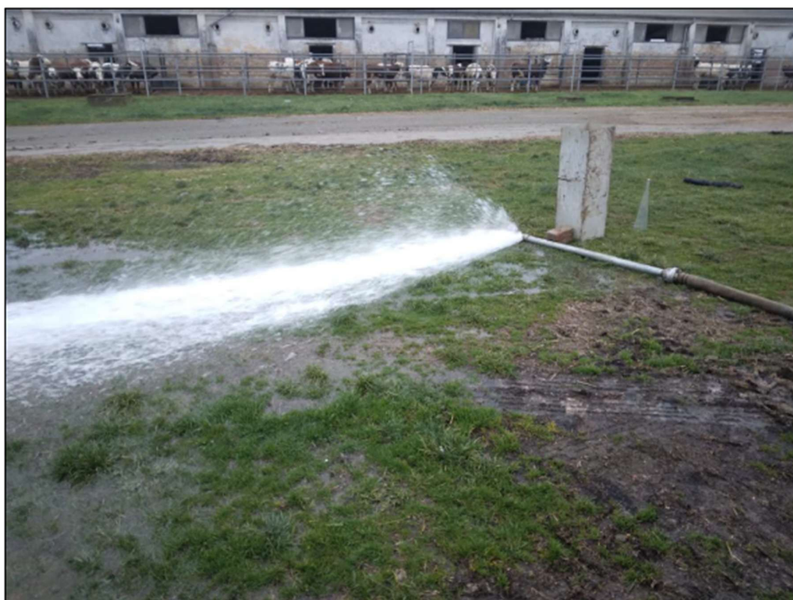
Slika 12. Pokusno crpljenje zdenca Z-2 (Izvor: Hidrogeološki elaborat, Vodovod-hidrogeološki radovi d.o.o.)
